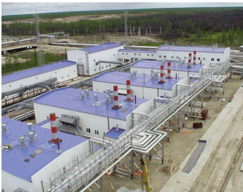
Фото 2. Установки ОР16 на Южно-Русском месторождении, 7 агрегатов
