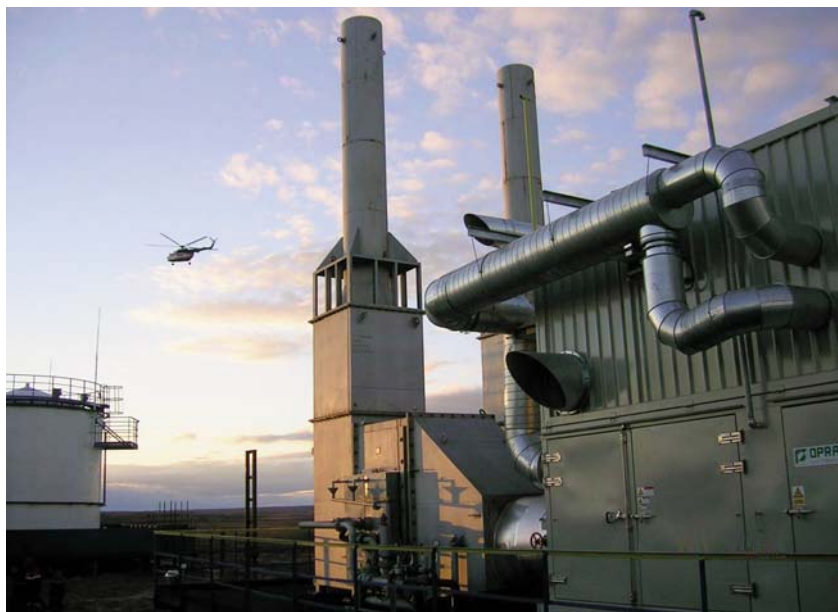
Фото 1. Две ГТУ OP16, эксплуатируемые на Тэдинском месторождении
